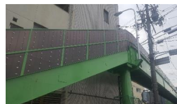
三田洞の歩道橋
