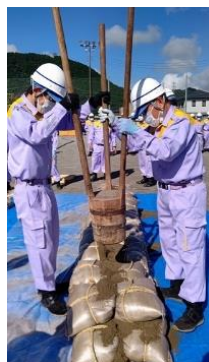
水防団による積み土嚢工法
